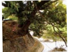
護岸には、ひび割れも・・・▶
